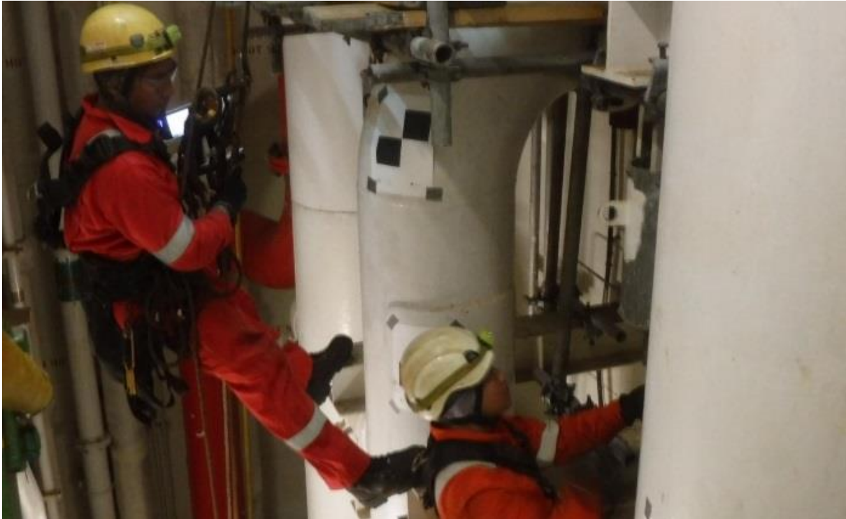
Die beiden Industriekletterer scannen mit dem Artec Leo 3D-Scanner Quelle: ASOM
